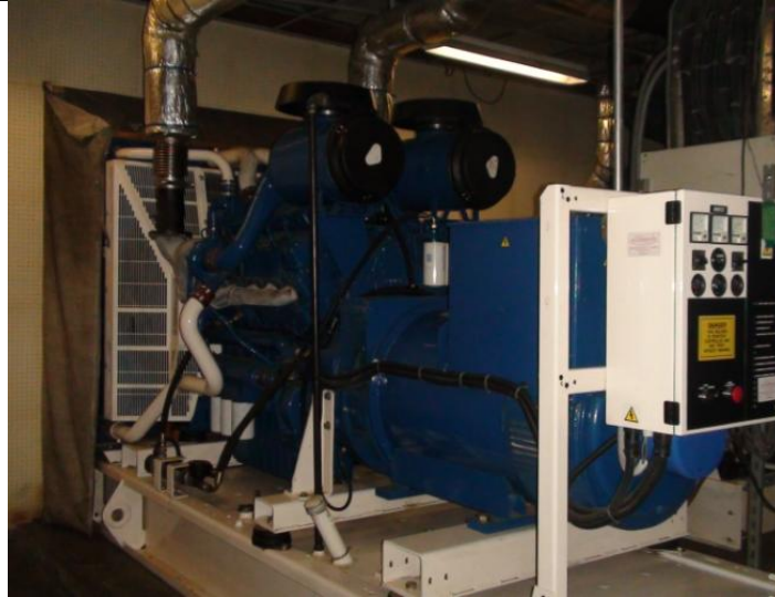
Planta eléctrica F.G. WILSON P660E de 750 Kva./600 KW ubicada en sótano del Centro Distrital de Salud.
